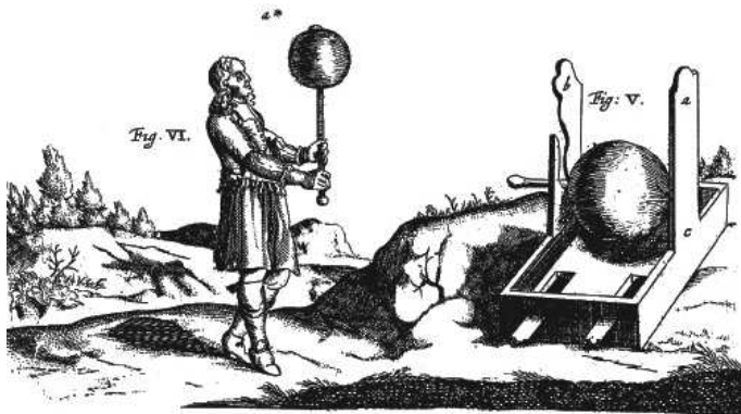
Рис. 4.7: Опыт Герике, где он держит перо в парящем состоянии над натертым серным шаром, и его электрическая машина.
